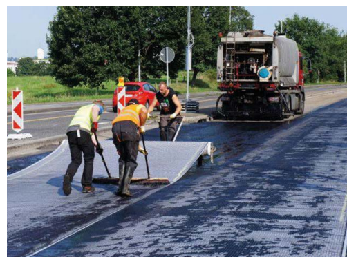
Rys. 5: Ręczna instalacja ADFORS GlasGrid
