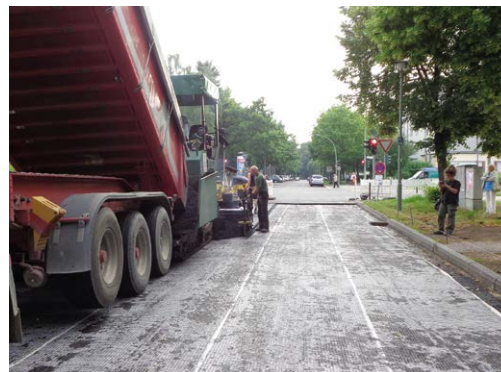
Rys. 9: Układanie nakładki asfaltowej
