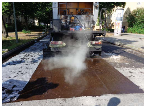
Rys. 3: Aplikacja emulsji przed ułożeniem GlasGrid CGL
